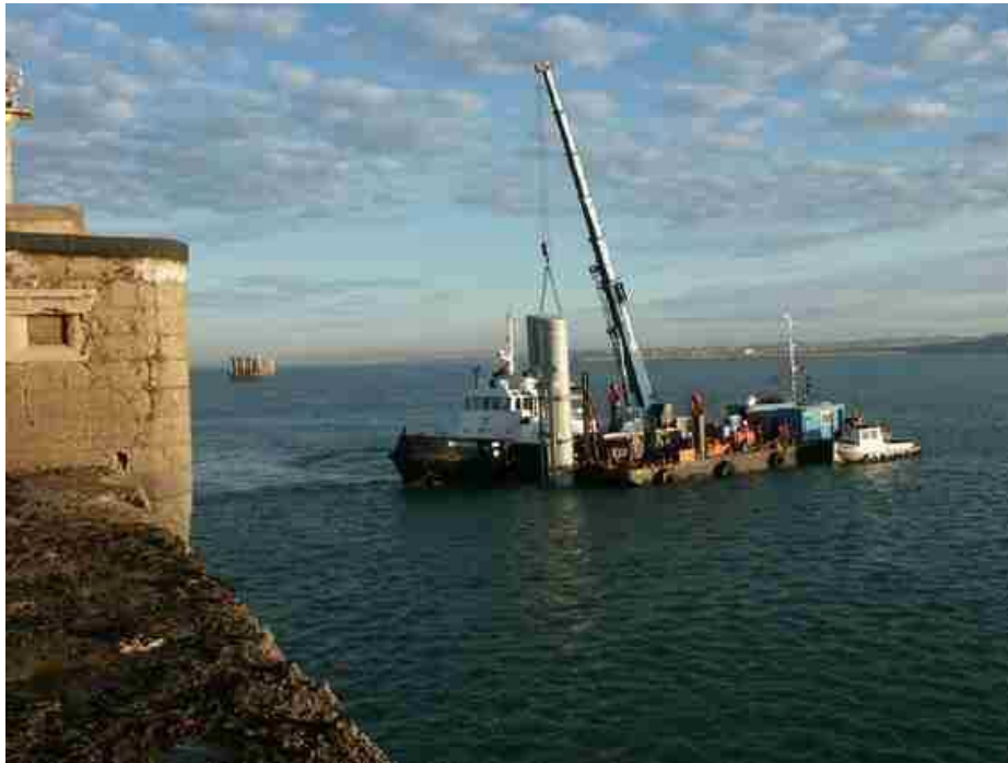
Figure 1 : Mise en place de l'infrastructure
